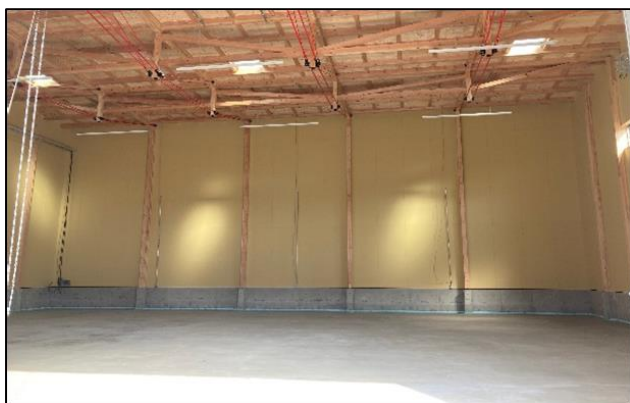
写真（仙台営業所資材倉庫）
